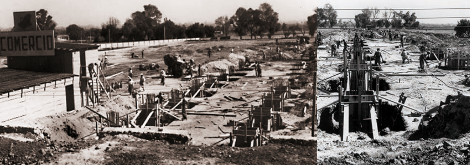
Obras de la Escuela Nacional de Comercio y Administración en la Ciudad Universitaria.
